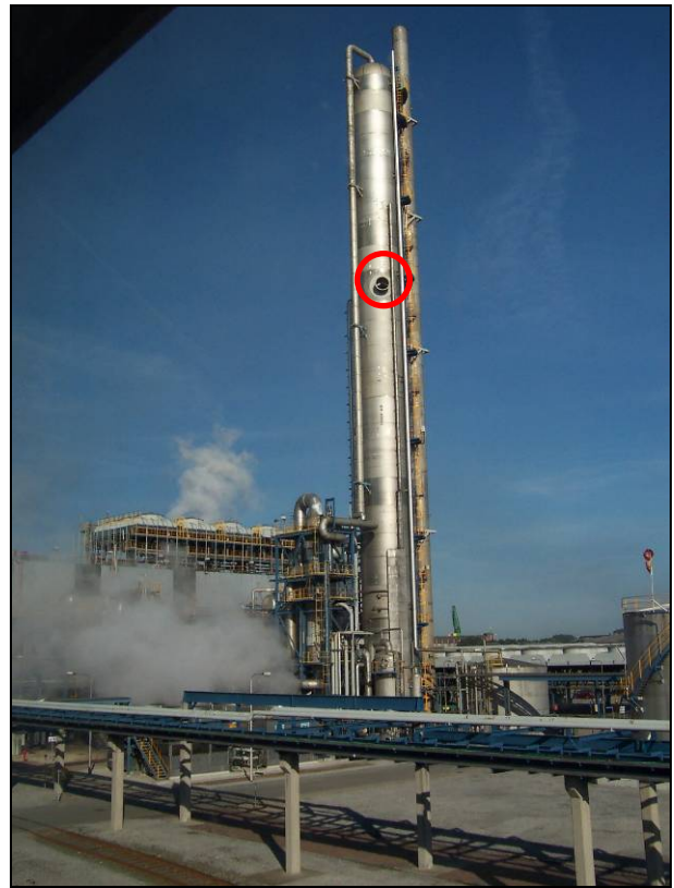
Broedplaats van een Slechtvalk bij Yara Sluiskil. De toren is 80 m hoog. Er werd gebroed in een onbereikbare nis op een hoogte van 54 m (rode cirkel). Foto: Fons Agterhuis & Harry Polderman.
